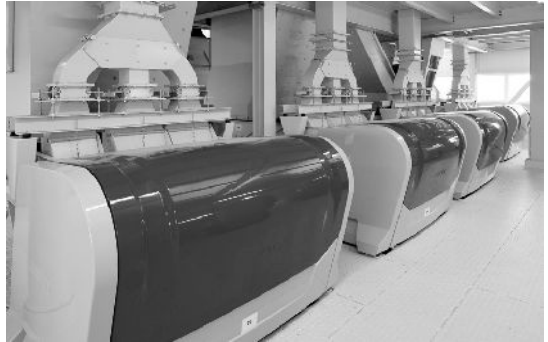
Optische Sortieranlagen im Recyclingwerk
